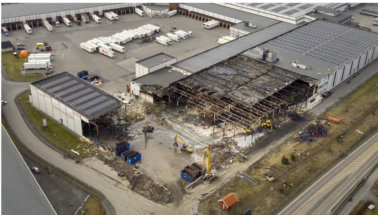
Figur 17: Etter at fryselageret var tæmt for innhold, ble den berørte delen av bygget revet (Bilde fra Aftenposten)
